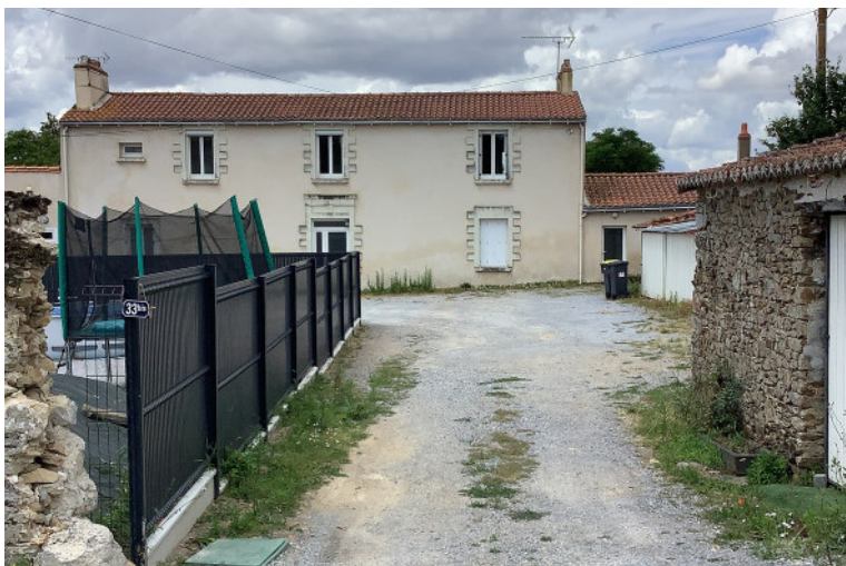
Maison de maître de Gasselin (En 2022)
